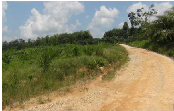
Gambar 13. Jalan Lintas Warga Yang Dibangun Oleh Perusahaan
