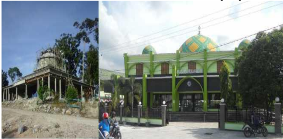
Gambar 5.12 Pembangunan tempat ibadah Musholla dan Masjid
