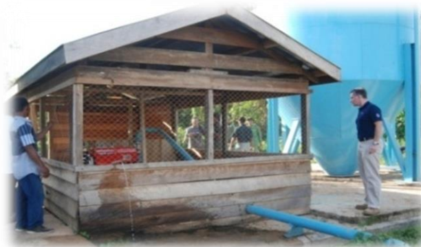
Gambar 16. Pembangunan Penampungan Air Bersih Bagi Desa Muai.
