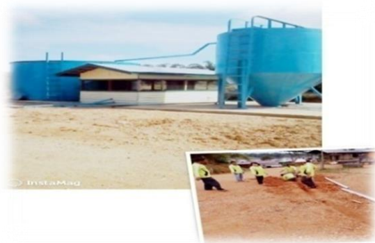
Gambar 9. Instalasi Air Bersih Milik Perusahaan di Desa Muai
