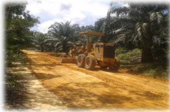
Gambar 14. Kontribusi Perbaikan Jalan di Desa Muai
