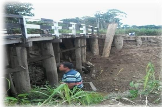
Gambar 13. Perbaikan Jembatan di Desa Muai
